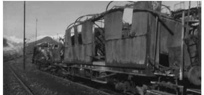
8. Mai 1945. Am Bahnhof Donawitz steht eine ausgebrannte und ausgeplünderte Schnellzugsgarnitur.
