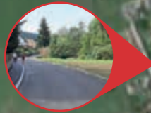
Sanierung der Straßen Im Tal & Hansbauernweg
