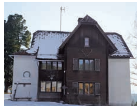
Die Schmollhube wird saniert.
