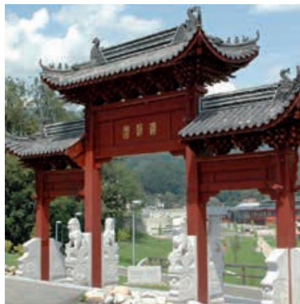
Sanierungsarbeiten beim chinesischen Torbogen
