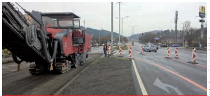
Bis zum Beginn der Ferien werden die Bauarbeiten abgeschlossen sein.
