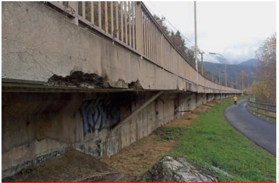
Die Stützmauer in der Zeltenschlagstraße wird saniert.
