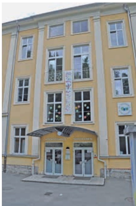
In der Volksschule Leoben-Seegraben werden umfangreiche Malerarbeiten durchgeführt.
