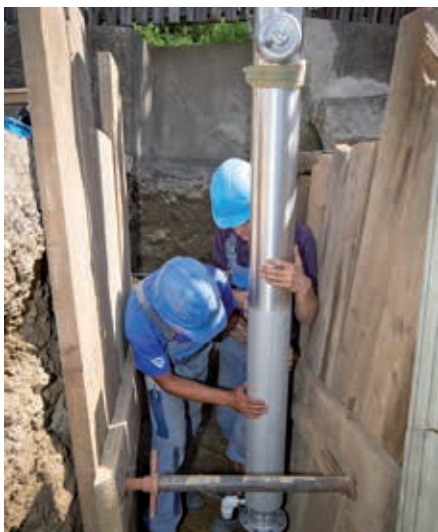
Die Wasserrohrverlegung geschieht auf engstem Raum.
