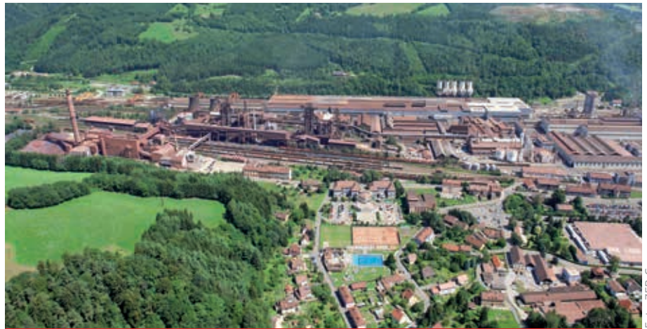
Im voestalpine-Werk in Leoben-Donawitz wird eine Stranggussanlage errichtet.
