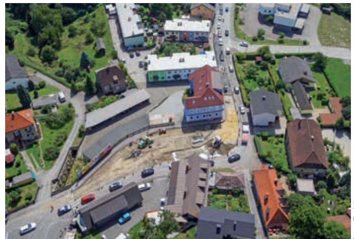
In Leoben-Seegraben wurden die beiden Fahrbahnpuren zusammengeführt.
