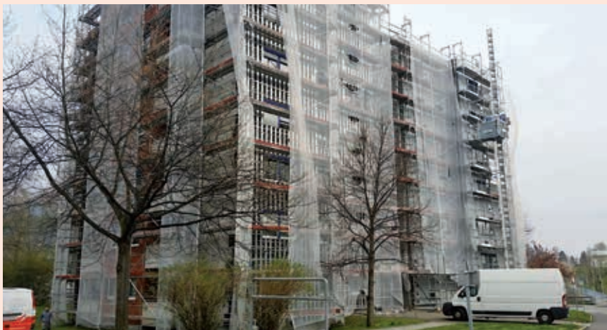
Die gemeindeeigene Wohnanlage in der Pebalstraße 33 wird thermisch saniert.
