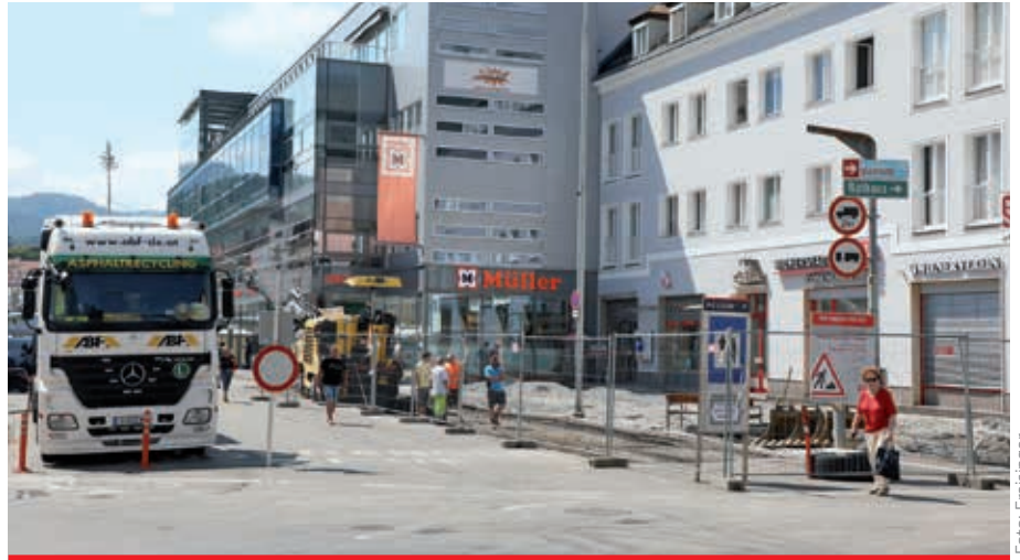
Die Umbauarbeiten für die neue Fußgängerzone sind bereits voll im Gange.
