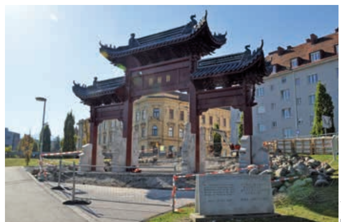
Die Sanierung des Torbogens erfolgt zur Zeit durch chinesische Fachkräfte.
