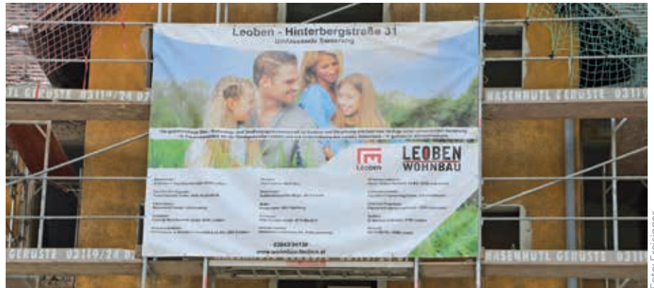
In der Stadt Leoben wird in den nächsten Monaten und Jahren umfangreicher Wohnraum geschaffen.
