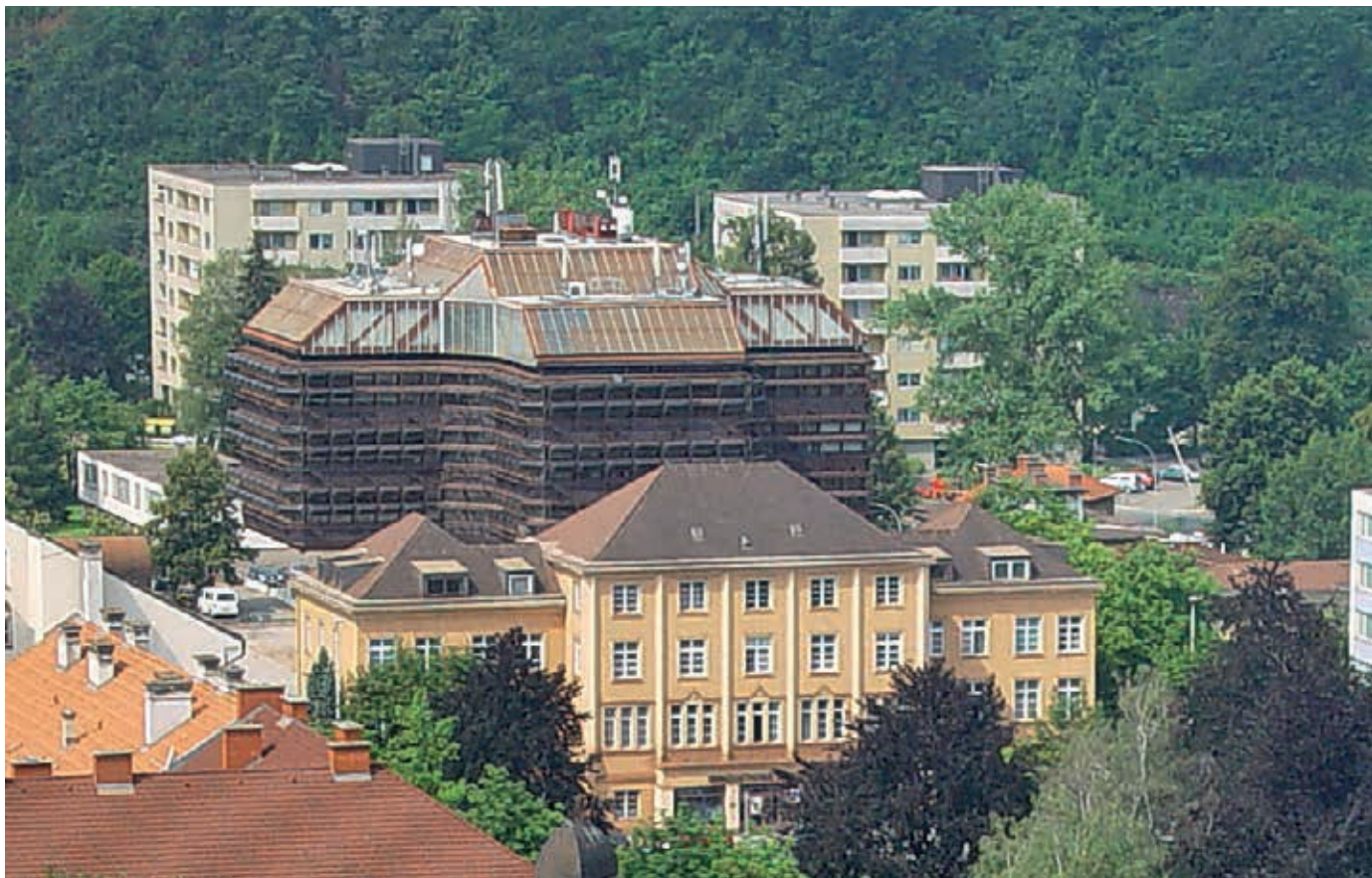
Das „Rostschwammerl“ in der Leobener Innenstadt war der ehemalige Forschungssitz der voestalpine.
