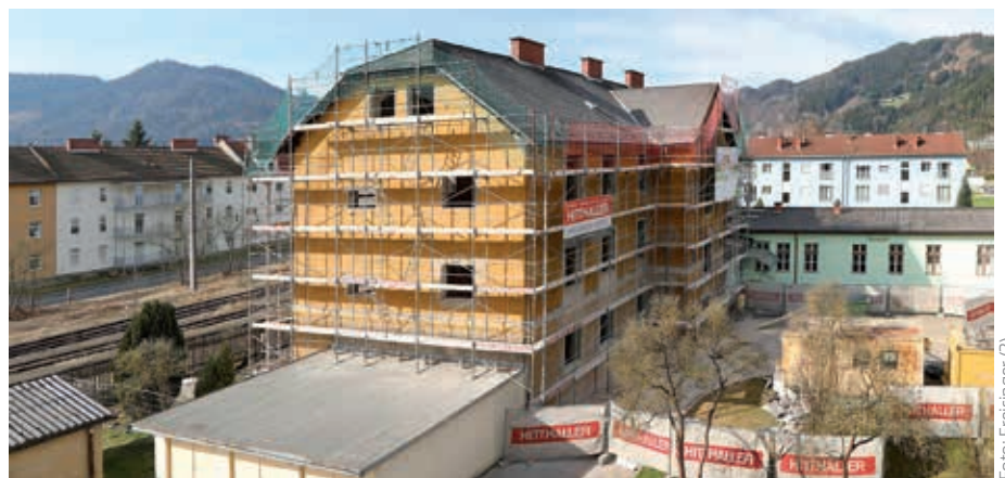
Wohnhaussanierung in Leoben-Hinterberg
