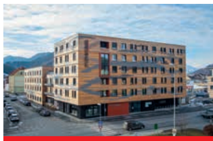
Mine Room, Josef Heißl-Straße
