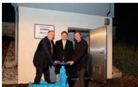
Neue Drucksteigerungsanlage am Veitsberg
