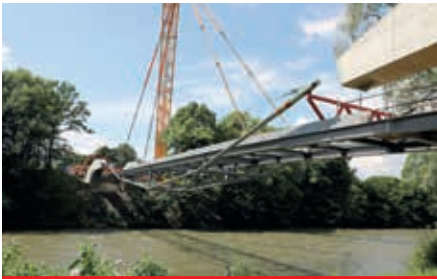
Einhängen der Brücke - 24.06.2019
