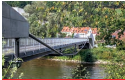
Fertigstellung der Brücke - 27.09.2019
