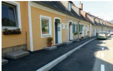
Neue Parkplätze Hippmannsgasse
