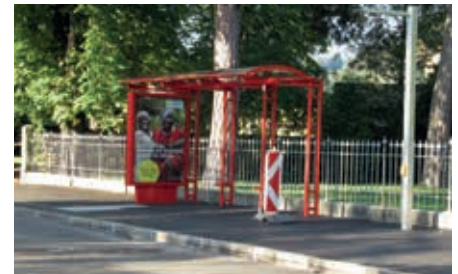
Verlegte Bushaltestelle „Moserhofstraße“
